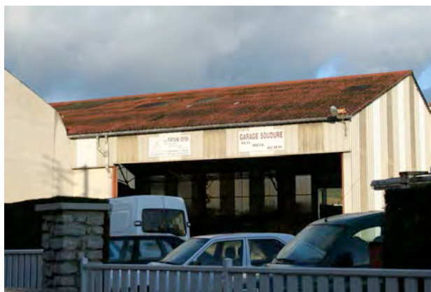
Atelier de mécanique
